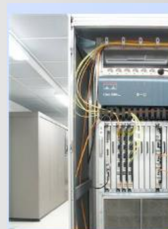
ELETTROMAGNETISMO (quadri elettrici)
