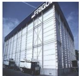
BASSE TEMPERATURE -25 °C (celle di refrigerazione)
