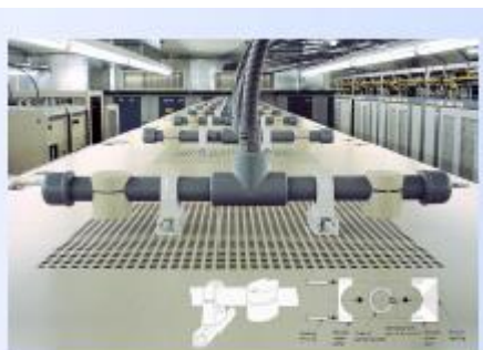
CIRCOLAZIONE ARIA (CED, cabine di telecomunicazione)
