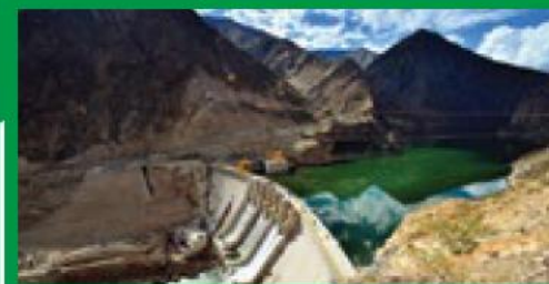
Centrale Idroelettrica Cerro De Aguila Callao
